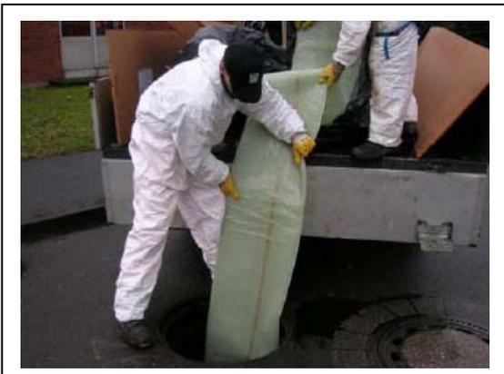
**Figure 4.3 : Traction de la chemise**
