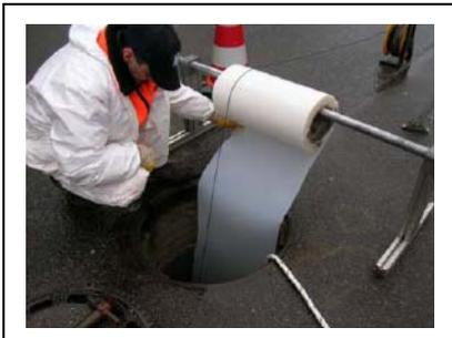
**Figure 4.1 : Insertion du préliner**
